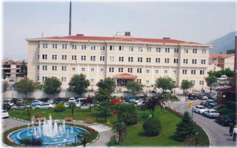
Resim 2: Bursa Yıldırım İlçe Kaymakamlık Binası
