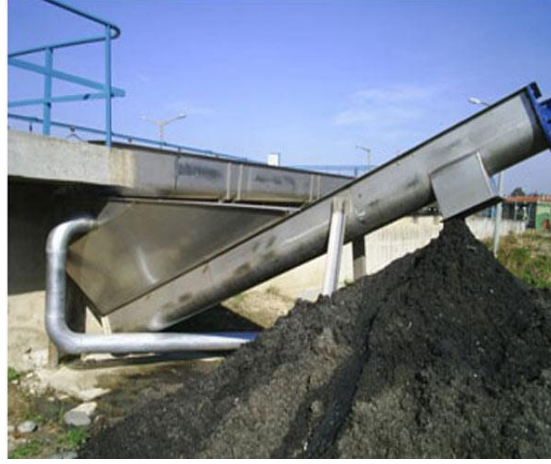
Resim 4: Kum Ayırıcı Yapısı
