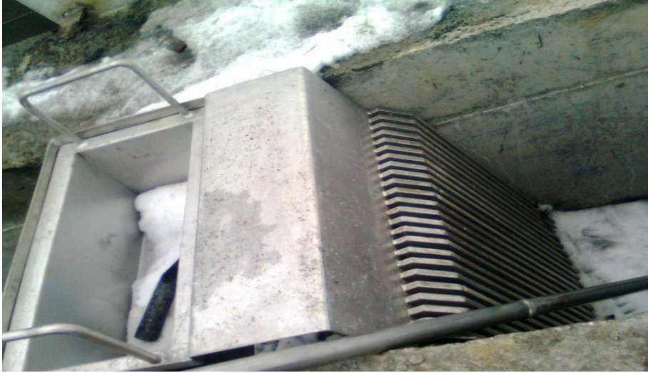
Resim 2: Kaba Izgara Yapısı
