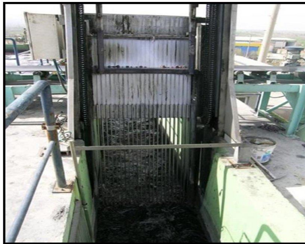
Resim 3: İnce Izgara Yapısı
