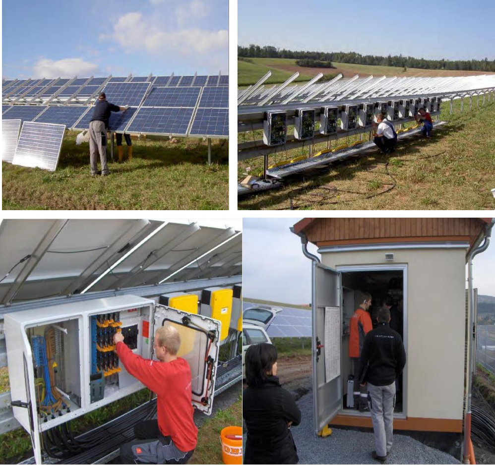
Şekil 49: Solar panel ve inverterlerin montajı
