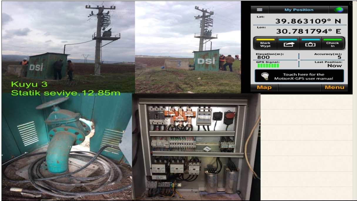
Şekil 25: Kuyu-3'de yapılan ölçüm çalışması görselleri
