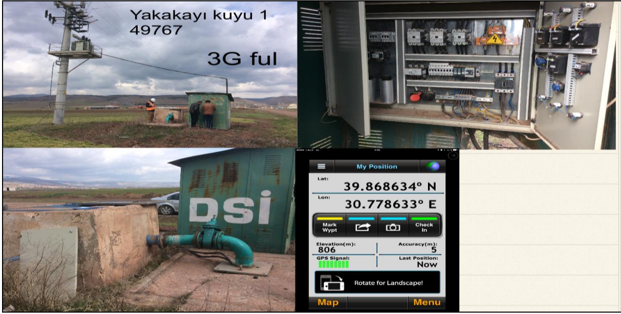
Şekil 19: Kuyu-1’de yapılan ölçüm çalışması görselleri
