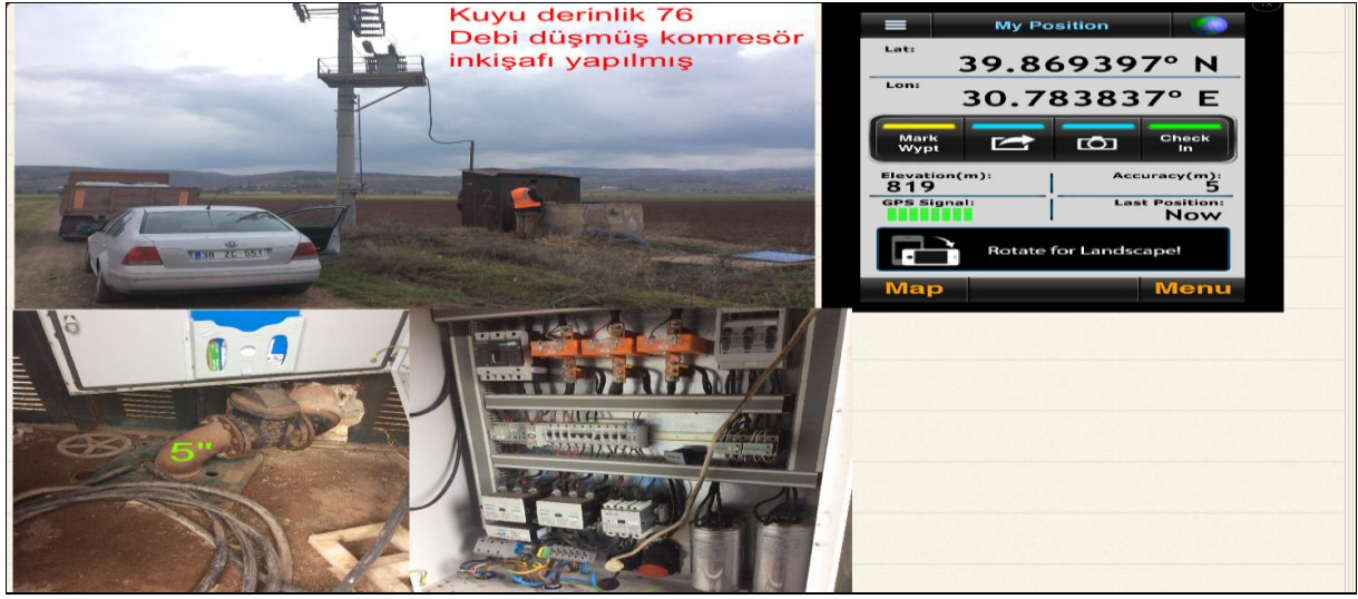
Şekil 22: Kuyu-2'de yapılan ölçüm çalışması görselleri
