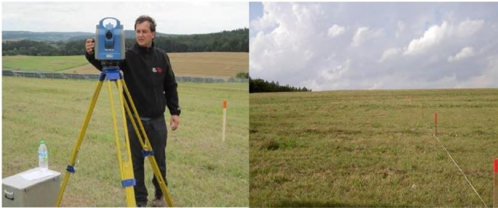
Şekil 47: Konstrüksiyonun tespit noktalarının belirlenmesi
