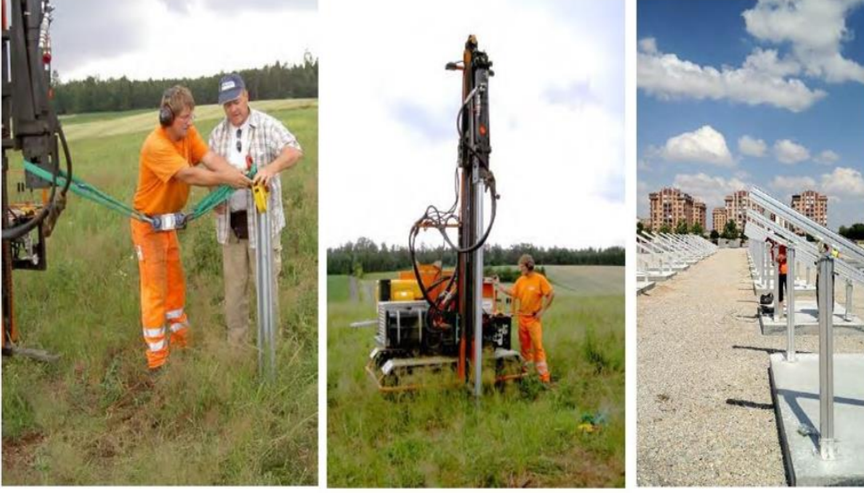
Şekil 48: Konstrüksiyonun zemine montajı
