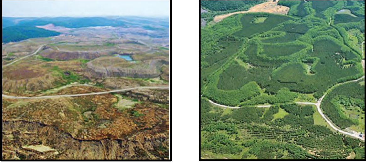
Şekil 139: İstanbul Kemerburgaz Rehabilitasyon Öncesi-Sonrası (Maden Sahaları Eylem Planı, 2015)
