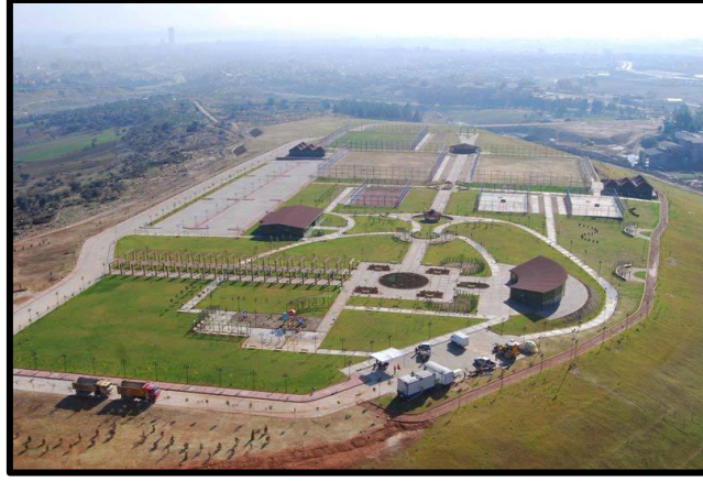
Şekil 136: Rehabilitasyon Sonrası Görüntü (Kaynak: Ertürk ve Görgün, 2011)
