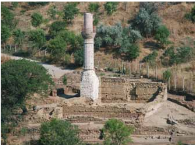
Yunan işgali sırasında yakılan ve yıkıntı halinde olan Emirler Camii'nin ne zaman yapıldığı bilinmiyor.
