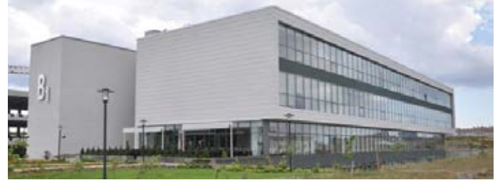
Yıldız Teknik Üniversitesi Teknoloji Geliştirme Bölgesi İdare Binası ve Kuluçka Merkezi
