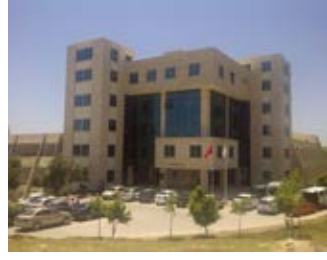
Mersin Teknoloji Geliştirme Bölgesi İdare Binası ve Kuluçka Merkezi
