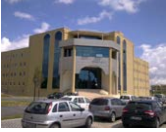
Istanbul Üniversitesi Teknoloji Geliştirme Bölgesi İdare Binası ve Kuluçka Merkezi
