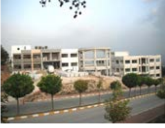
Sakarya Üniversitesi Teknoloji Geliştirme Bölgesi İdare Binası ve Kuluçka Merkezi
