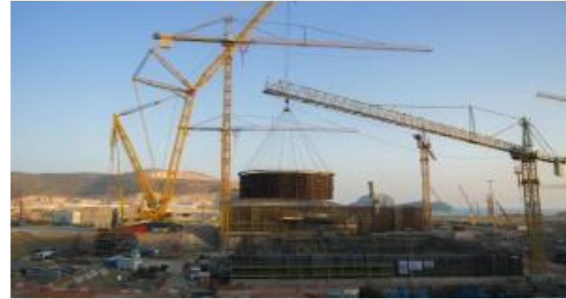
1 Nolu Ünite Reaktörü Üzerine İnşa Edilen Koruma Binası 2. Katmanı Montajı
