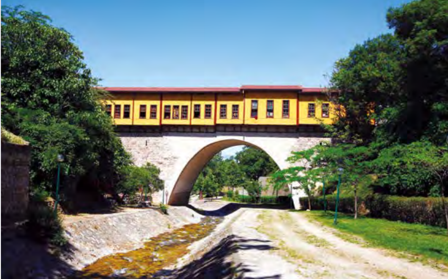
Irgandı Köprüsü Dünyadaki 4 çarşılı köprüden biridir. Kagir ve tek katlı köprü, 1442 yılında inşa edilmiştir.
