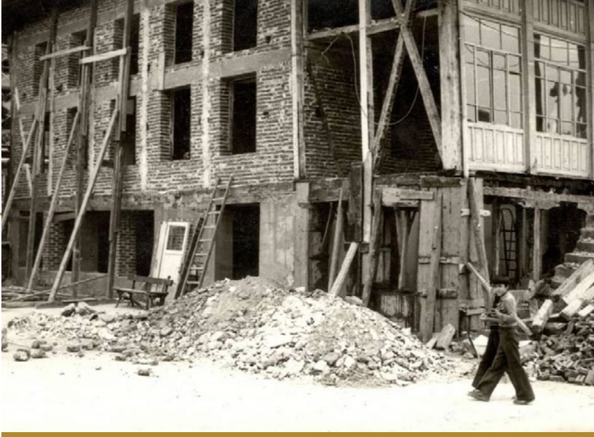
10-Tekke Doğu Cephe, 1980
