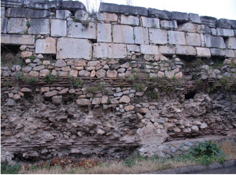
Resim 305: Sur duvarlarının ikinci evresinde yoğun olarak kullanılan devşirme malzeme.
