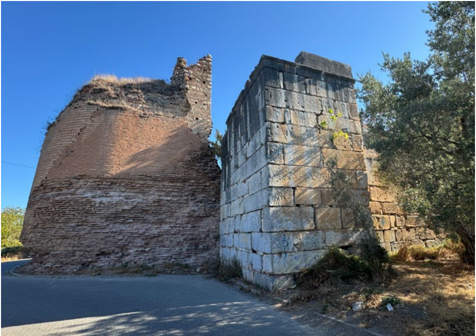
Resim 307: III. Leon tarafından onarılan Saray Kapısı'nın güneyindeki sur duvarı.
