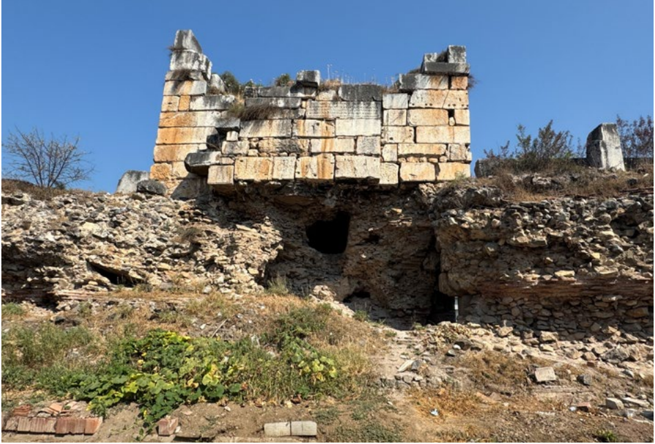
Resim 306: III. Leon'un onarım yazıtı ile birlikte sur duvarı, İstanbul Kapısı batısı.
