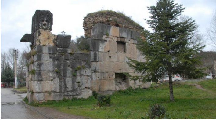
Resim 325: İç duvarda kullanılan devşirme mermer elemanlar.
