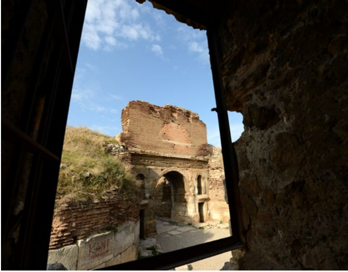
Resim 330: Lefke Kapısı Onur Takı'na kır cephesinden bakış.
