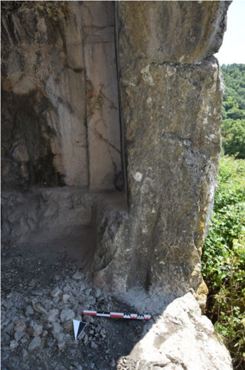
Resim 263: Kapı profilinden detay.
