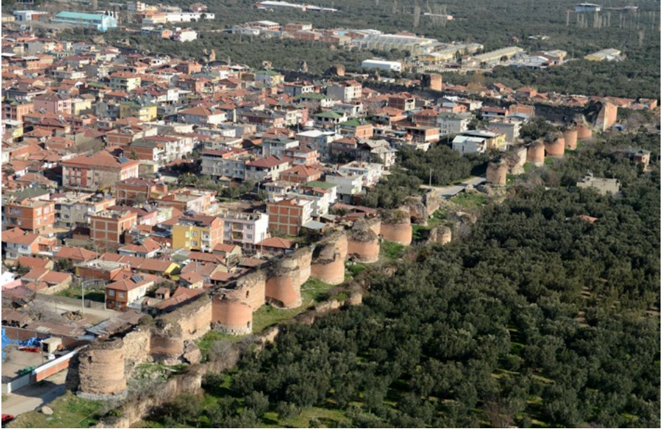
Resim 303: Nikaia'yı çeviren Roma Dönemi sur duvarı ve kuleleri.
