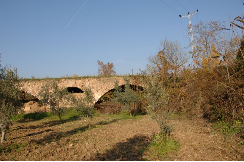
Resim 291: Traianus Köprüsü / Koca Köprü.
