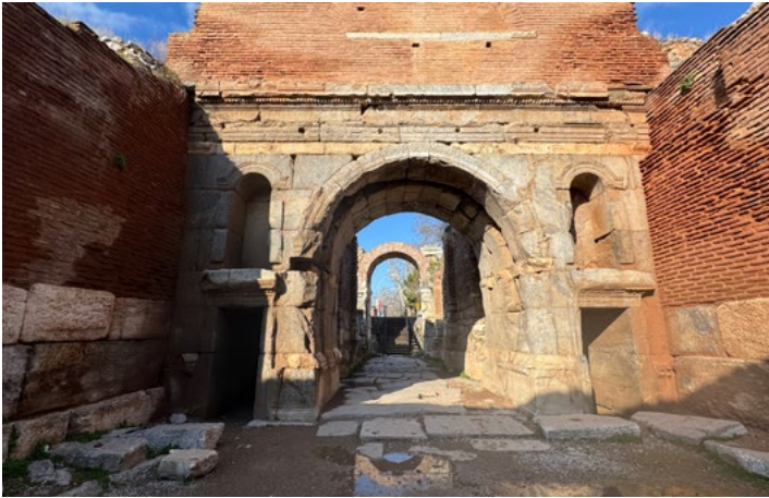
Resim 331: Lefke Kapısı Onur Takı'na kır cephesinden bakış.
